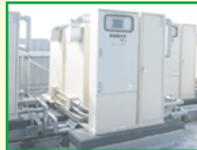
■ 夜間電力蓄熱式蒸気発生器 「蒸気源」
